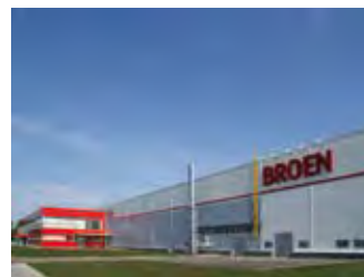
Производственный комплекс BROEN в Коломне
